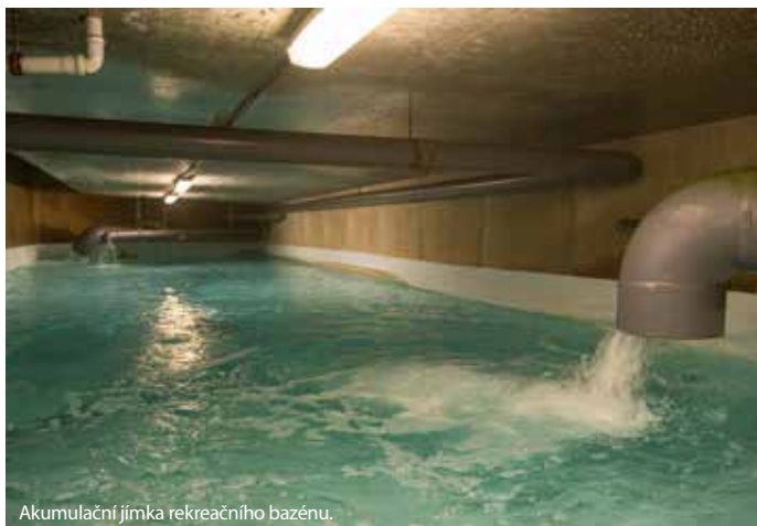
Akumulační jímka rekreačního bazénu.
