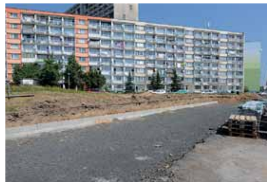
Ve Stavbařské ulici se už parkoviště staví
