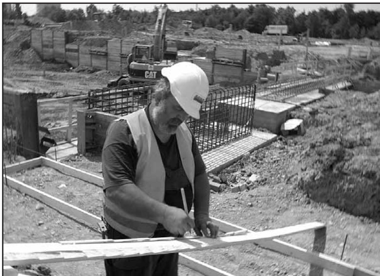
Dělníci stavebních firem pracují na základech zimního stadionu. (foto: tb)
