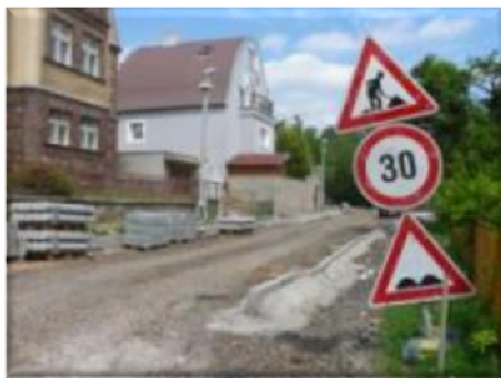
Rekonstrukce komunikace ul. Jabloňová
