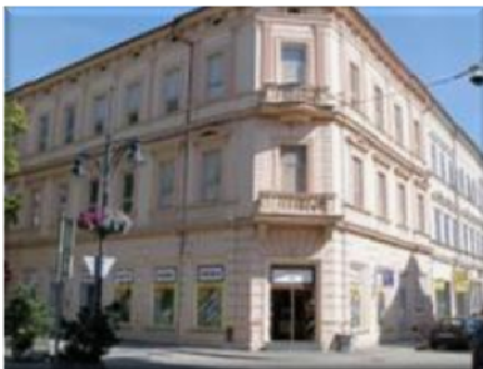
Rekonstrukce čp. 38 – ČVUT (3.NP)
