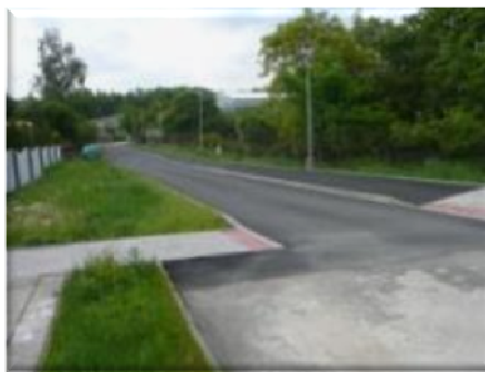
Rekonstrukce komunikace ul. C
