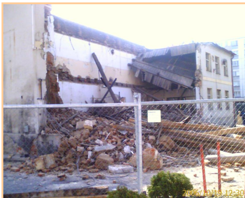
Demolice bývalé výpravní budovy ČSAD 19. 10. 2006 na Žižkově náměstí
