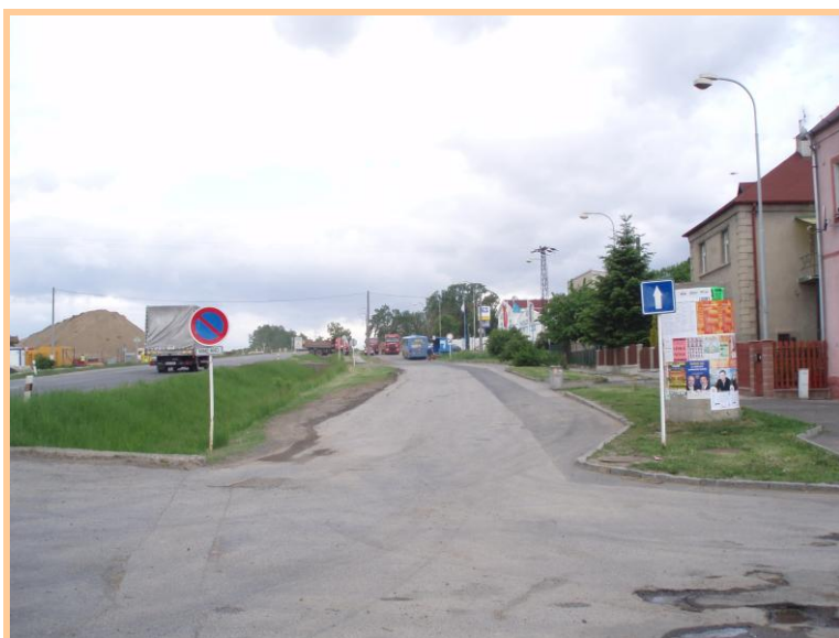
Původní silnice I/13 s náspem pro budoucí připojovací rameno (vlevo) – pohled směr Kadaň.
