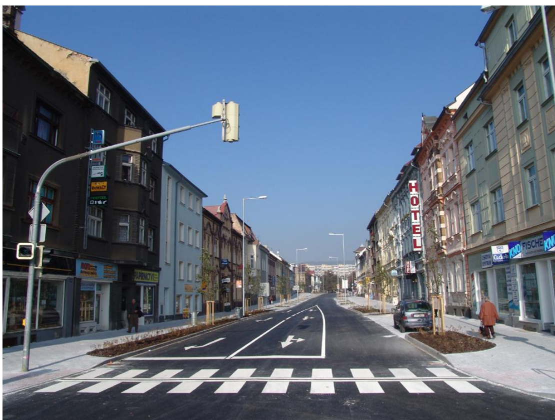
Novotou „vonící“ opravená vozovka a nové chodníky v ulici Blatenská.
