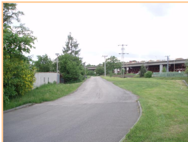
Mostní objekt nad Novými Spořicemi v začátku stoupání do Krušných hor.
