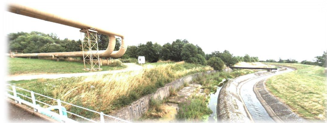
Obr.: Vyústění Hutné do Krušnohorského přivaděče
