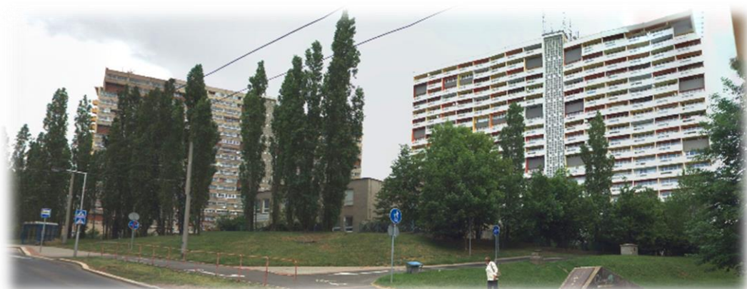
Chomutov: sídliště Březenecká
