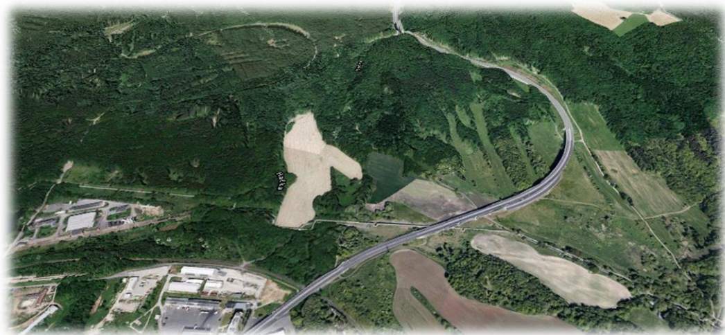
Chomutov: výstupní estakáda silnice I/7
