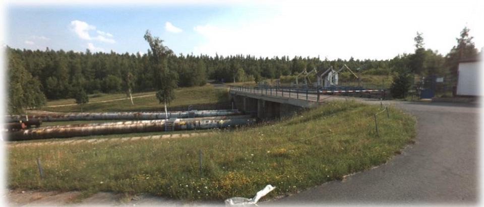
Obr.: Převedení Bíliny na potrubí v Ervěnickém koridoru
