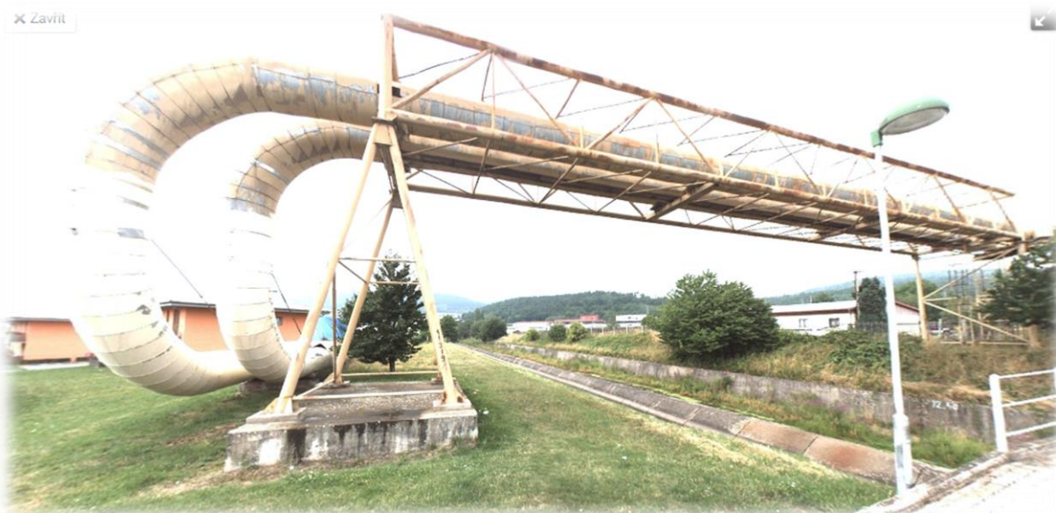
Obr.: Obrázek za všechny – převedení teplovodu v Málkově přes Podkrušnohorský přivaděč.
