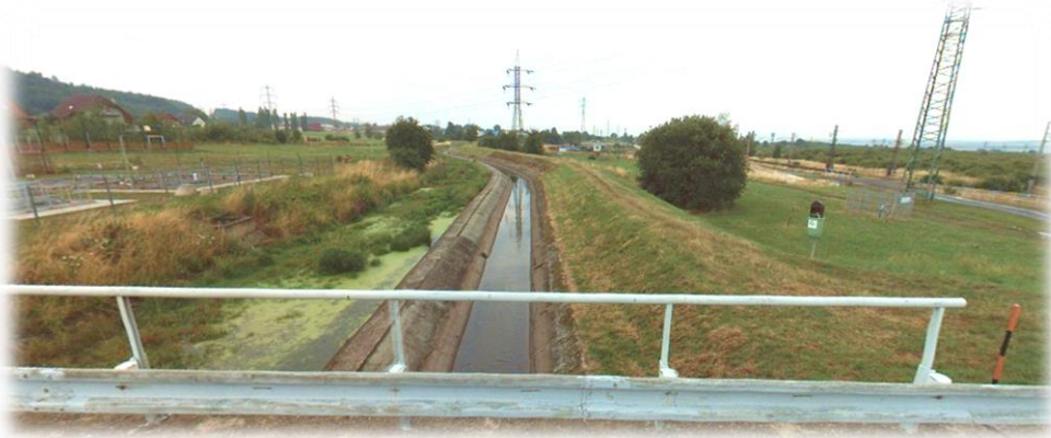
Obr.: Průběh Krušnohorského přivaděče v Málkově - vpravo je území, které přechází do povrchového dolu
