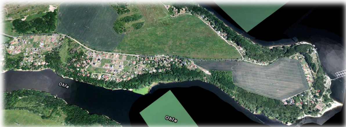
Obr.: Chatová zástavba při Nechranické přehradě
