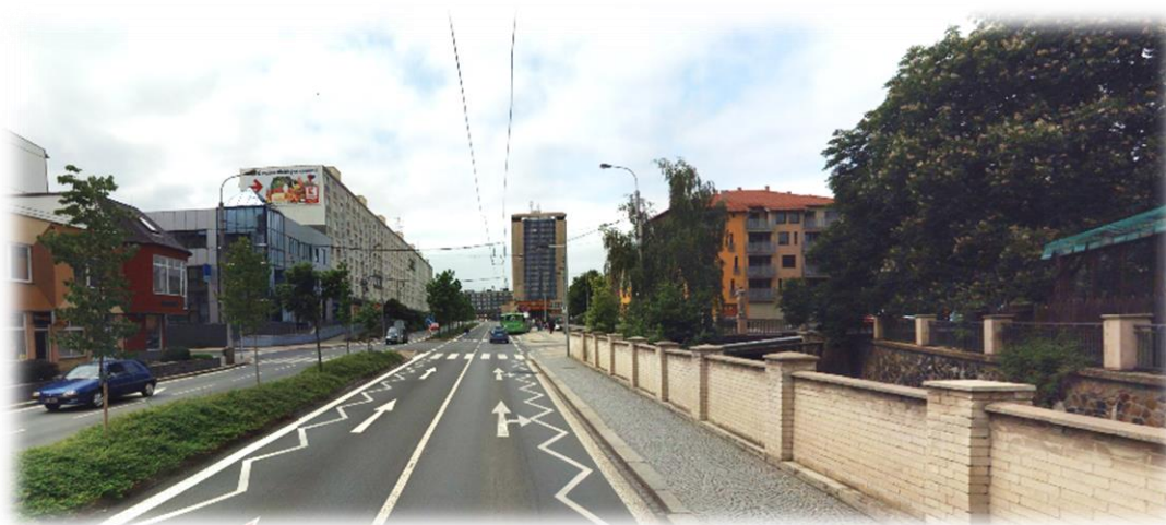
administrativní budova Palackého – nyní v rekonstrukci s novým obvodovým pláštěm
