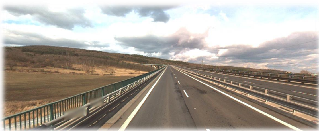
Obr.: Nástup silnice D7 do Krušných hor
