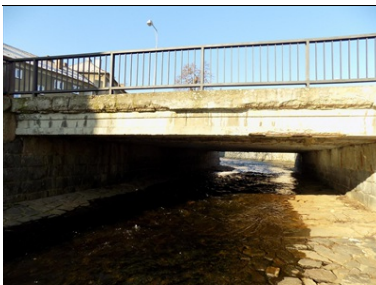
pohled na most zprava
