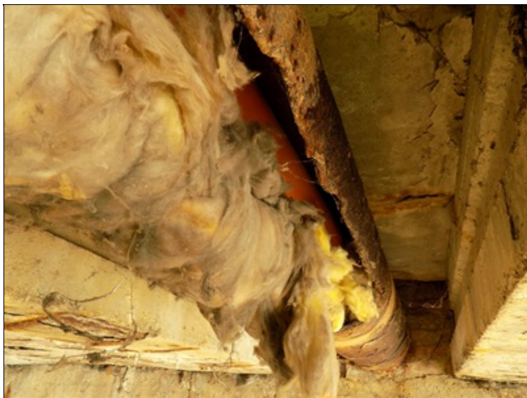
trubka mezi nosníky vpravo - zaústění do OP2
