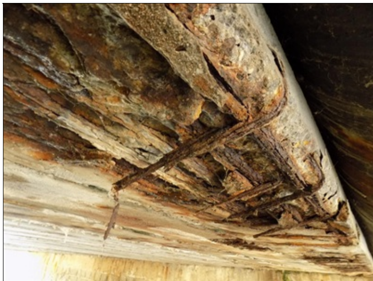
levý krajní nosník před trubkou (NP32) směrem k OP1
