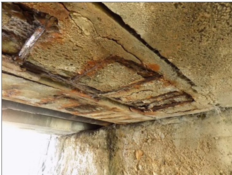
nosníky NP29~NP32 v uložení na OP2
