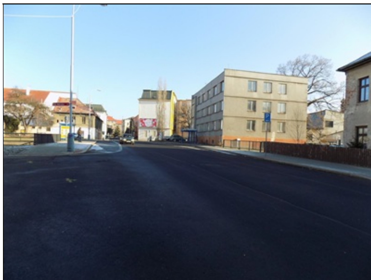
pohled na most po směru staničení
