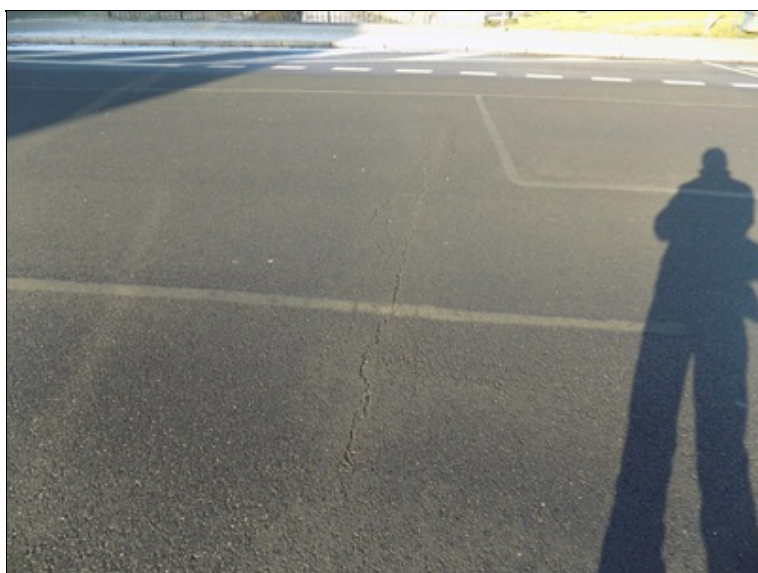
trhlina ve vozovce nad OP2
