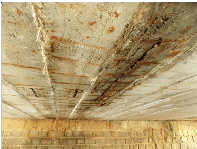
nosníky NP17~NP19 od opěry OP2
