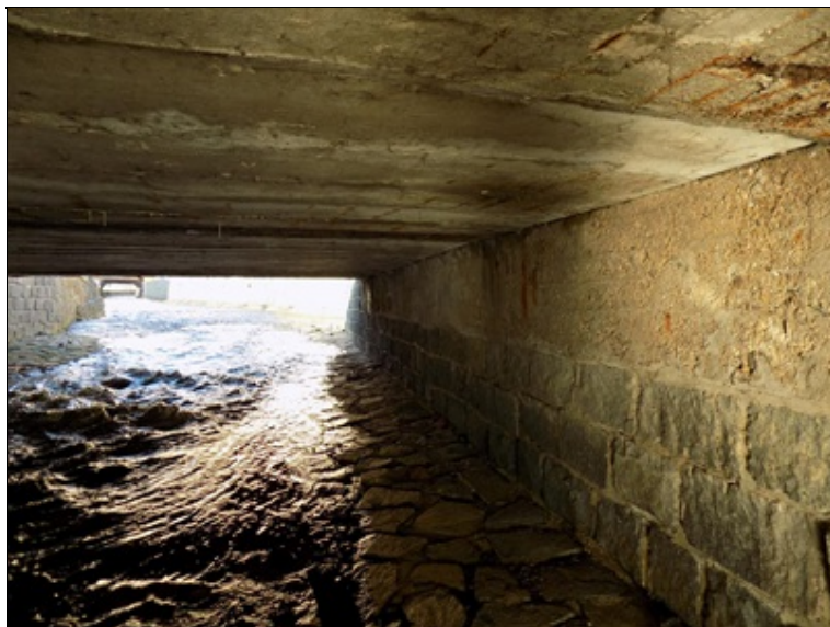
pohled na nosníky od OP2 směrem doleva (vpravo uložení NP13)
