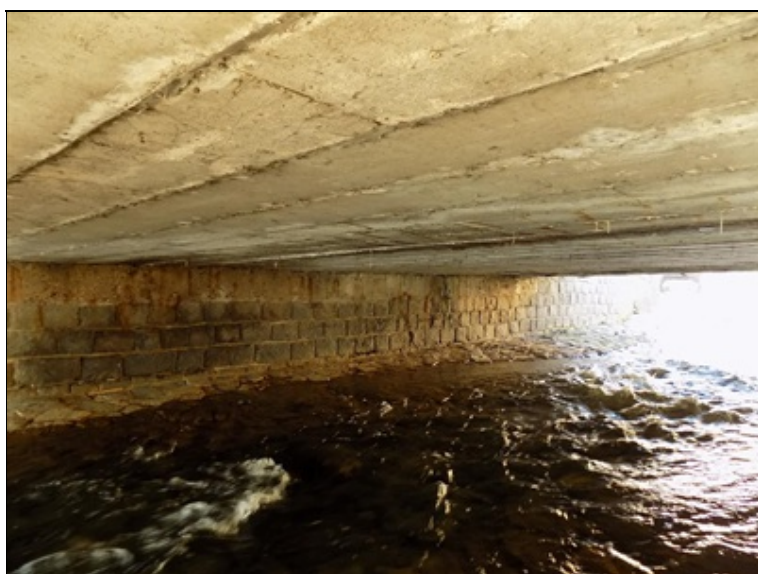
pohled na nosníky od OP2 směrem doleva
