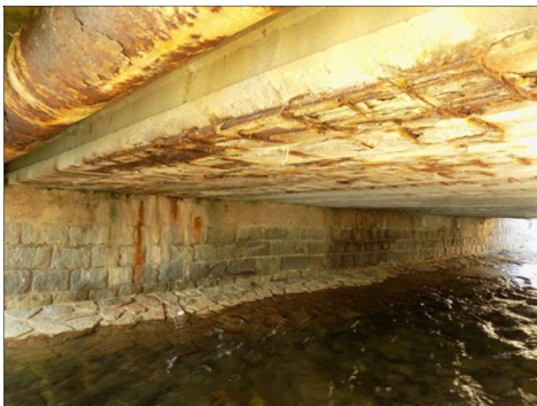
opěra OP1 zprava
