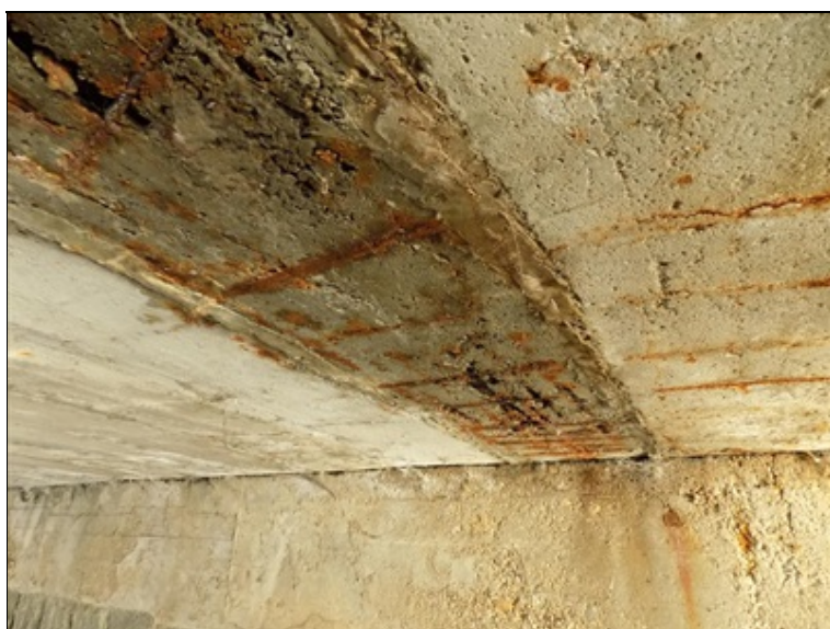
nosník NP19 v uložení na OP2
