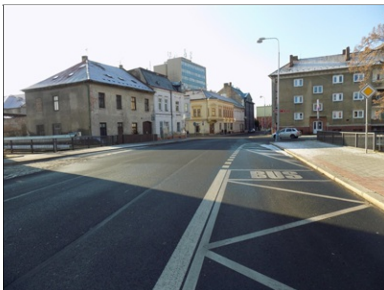
pohled na most proti směru staničení
