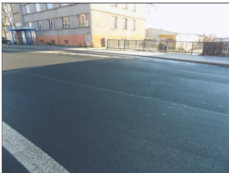
pohled na vozovku nad OP1 (zleva)
