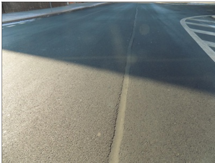
podélná trhlina na vozovce (proti směru staničení)
