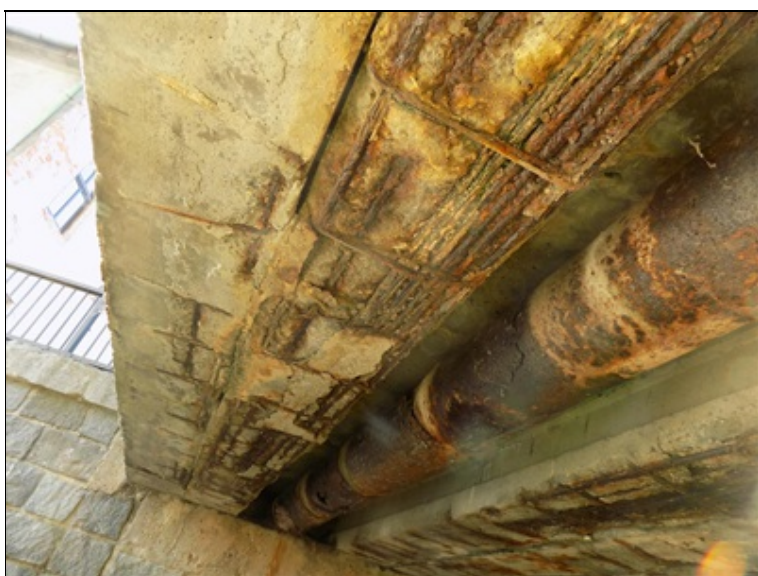
pravé krajní nosníky
