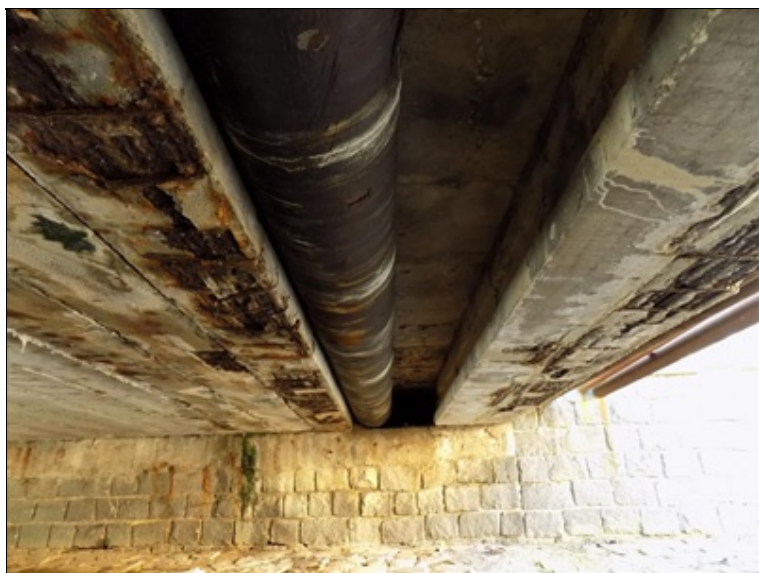
levé krajní nosníky (NP29~NP32 a NP33~34) od opěry OP2
