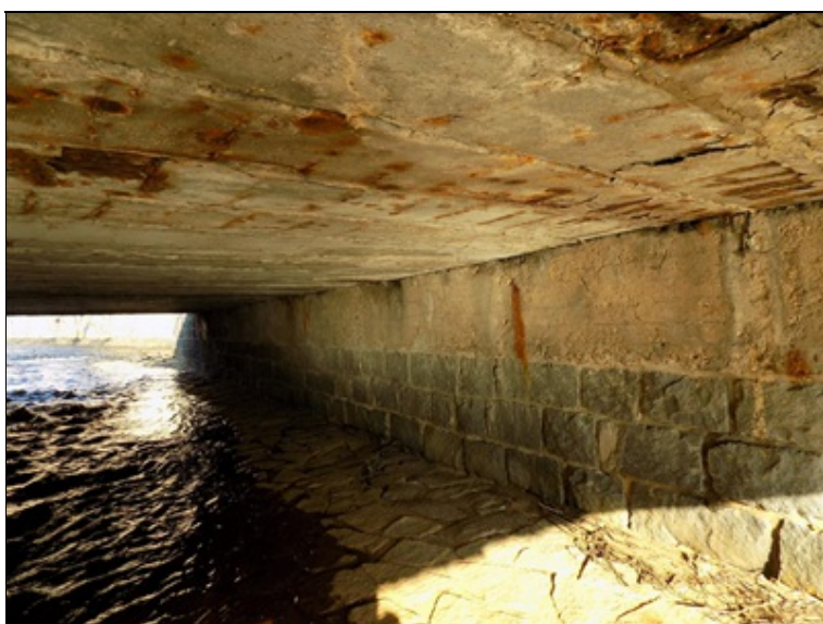
opěra OP1 zprava
