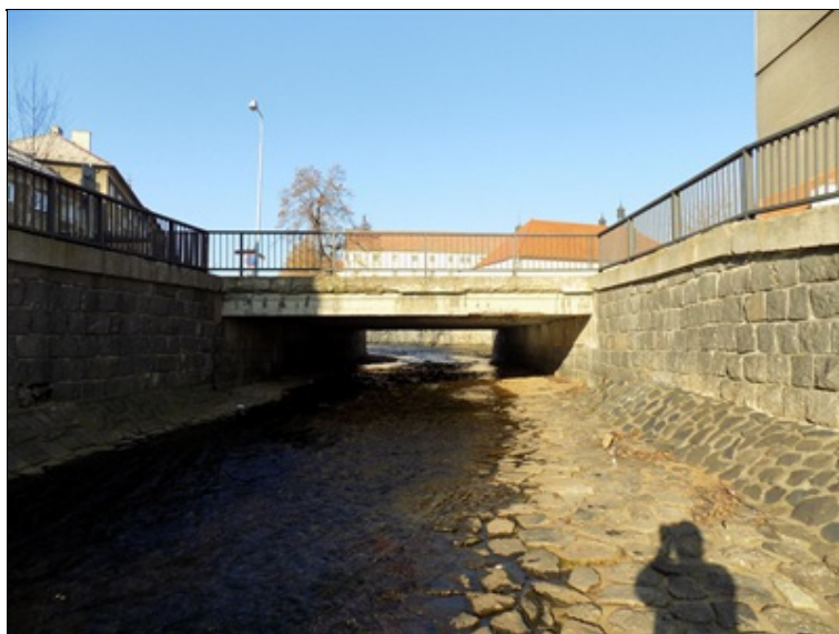
pohled na most zprava
