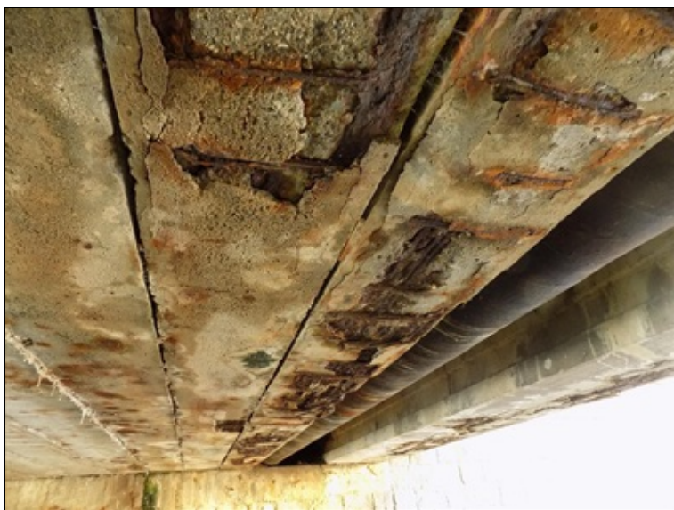
levé krajní nosníky (NP29~NP32) od opěry OP2
