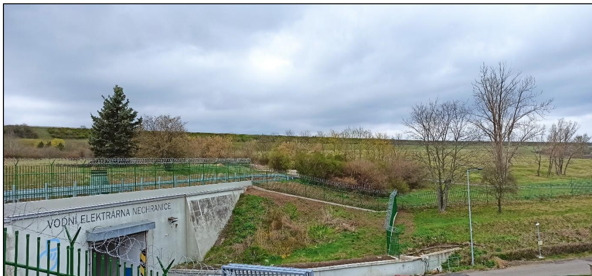
Obr. 17 – Sypaná hráz a vodní elektrárna v.n. Nechranice
