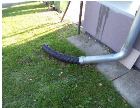
Prodloužení odtoku dešťového svodu pomocí plastového flexi potrubí
