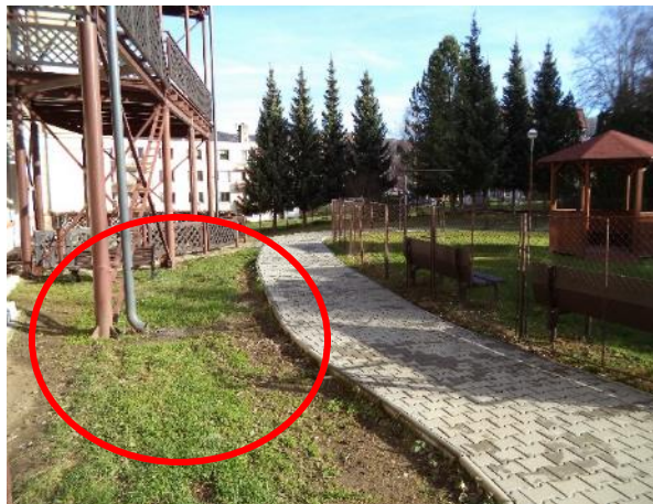
Jednoduché odvedení srážkových vod na nebezpečnou plochu pozemku pro vsak.
