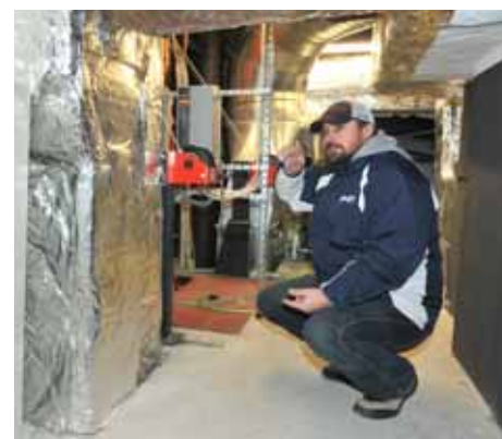
Vedoucí zimního stadionu Daniel Mašek vysvětluje, jak funguje strojovna vzduchotechniky
