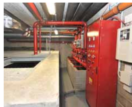
Strojovna požárního systému, která automaticky ovládá požární rozstřikovače
