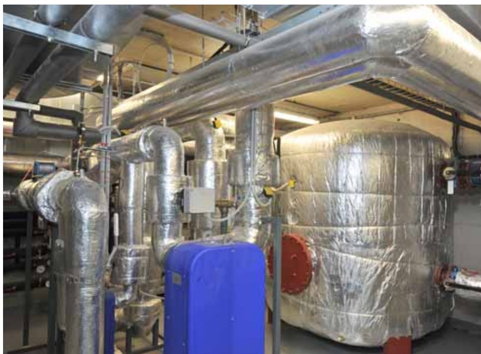
Výměňková stanice s akumulační nádobou, která vyrábí teplo a teplou vodu ze zbytkového tepla z chlazení
