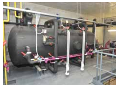
Expanzní nádrž strojovny chlazení ledových ploch
