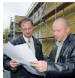
Náměstek primátorky Jan Řehák a ředitel městské policie Vít Šulc při kontrole rekonstrukce služebny.
