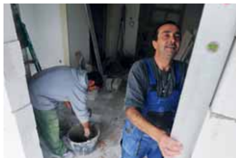
Práce na nové služebně městské policie jsou v plném proudu
