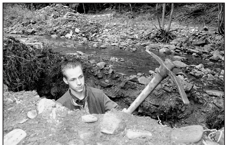
Před vlastní stavbou můstku je potřeba vyhloubit jámy pro základy, na snímku při této činnosti Karel Listopad z firmy Nord Stav. (foto: stb)
