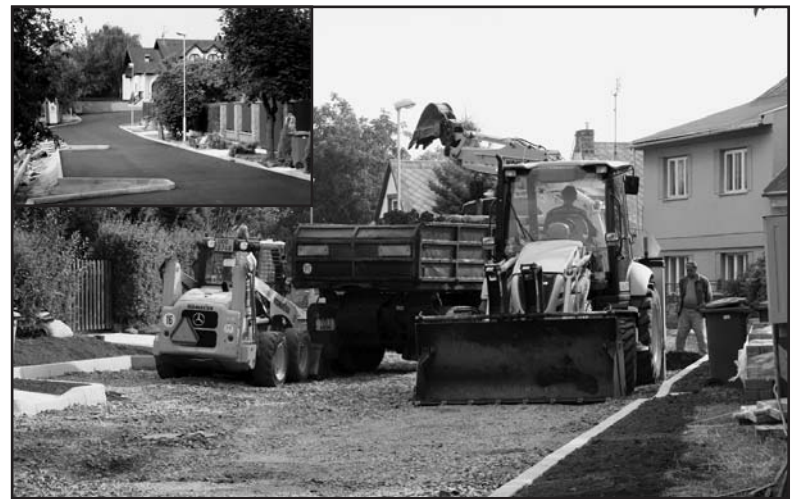
Lipanská ulice během prací. Ve výřezu její vzhled po rekonstrukci. (foto: mz)
