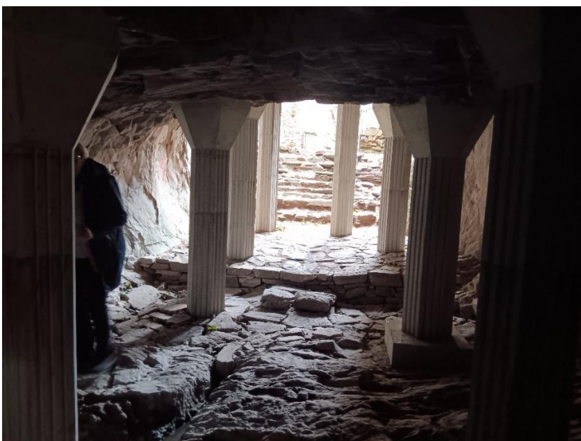
Zajišťovací práce na hradě Hasištejn, foto: odbor stavební úřad
