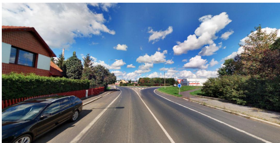
Obr. č. 3 – Stávající stav (pohled z ulice Pražská – příjezd do města)
