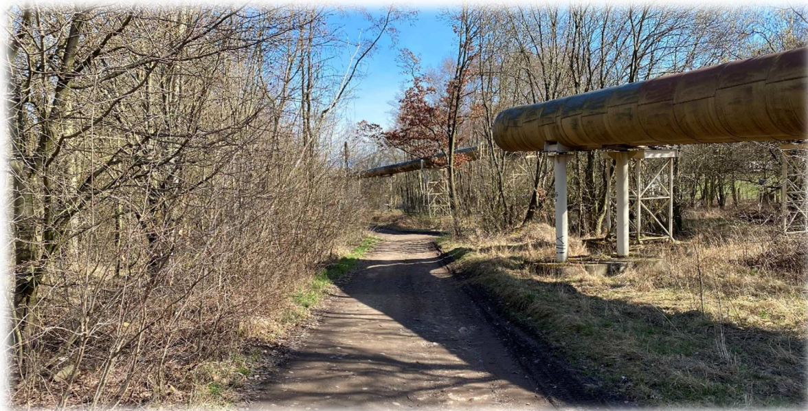
Obr.: současný stav účelových komunikací
