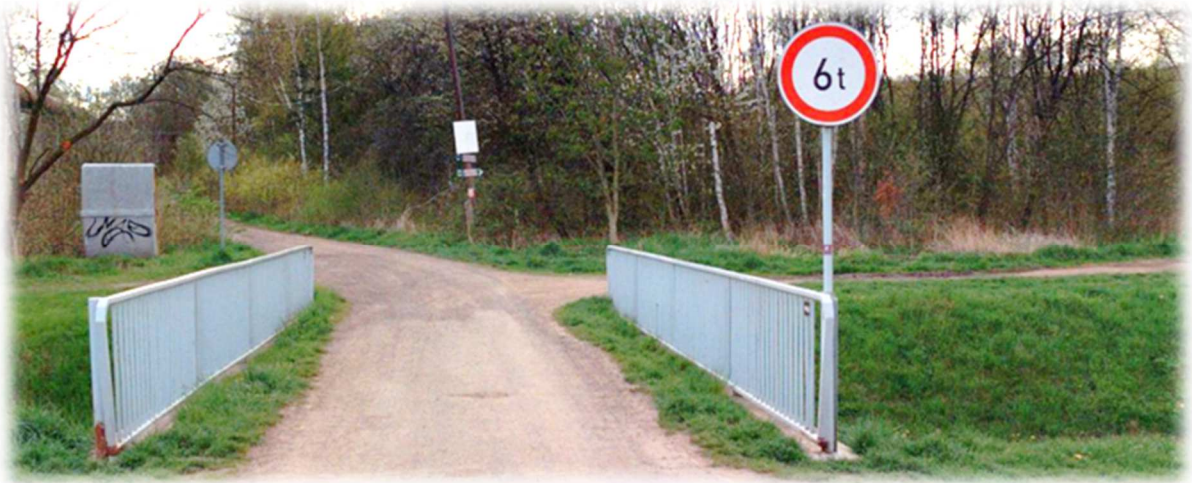
Obr.: Přemostění Podkrušnohorského přivaděče.
