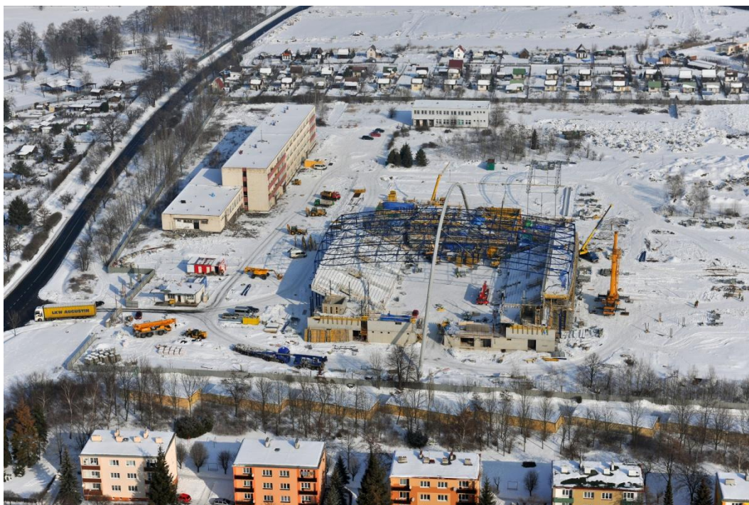
Letecký pohled na stavbu zimního stadionu a tréninkové haly z počátku února 2010.
