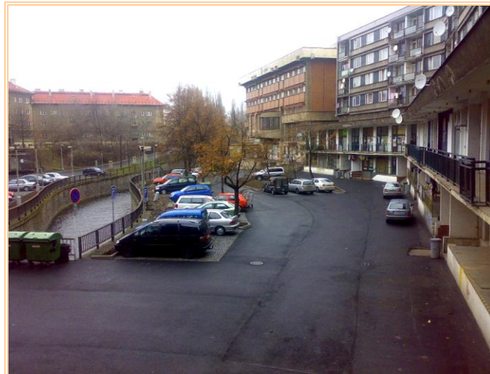
Rekonstrukce tzv. "podkovy" na ulici Palackého.
