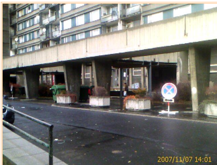
Uzavření parkovacích míst - ul. K. Světlé v 11/2007 - havarijní stav obslužné rampy u vstupů do panelových domů.
