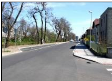
Rekonstrukce Alešova ul. (5,6 mil. Kč)
