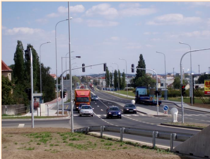
Slavnostní otevření průtahu silnice I/13 městem 30. 8. 2007, světelnou signalizací ovládá kamerový systém při najetí vozidla z vedlejší silnice.
