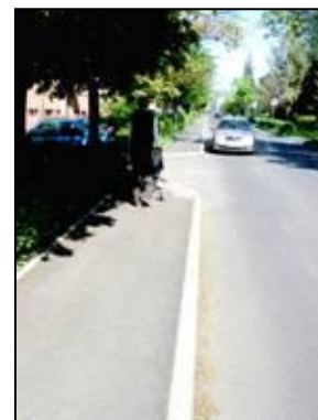
Rekonstrukce Sluneční ul.
