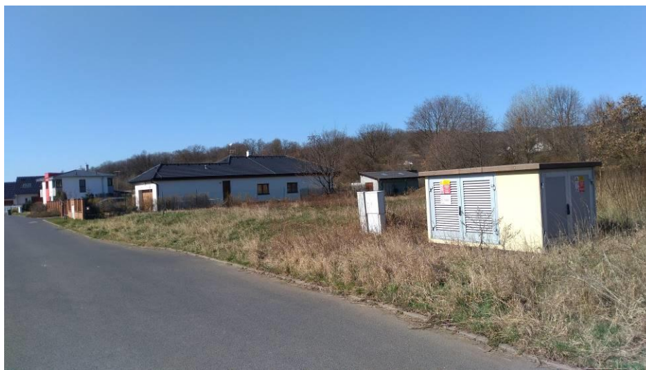
Stávající trafostanice na okraji řešené lokality
